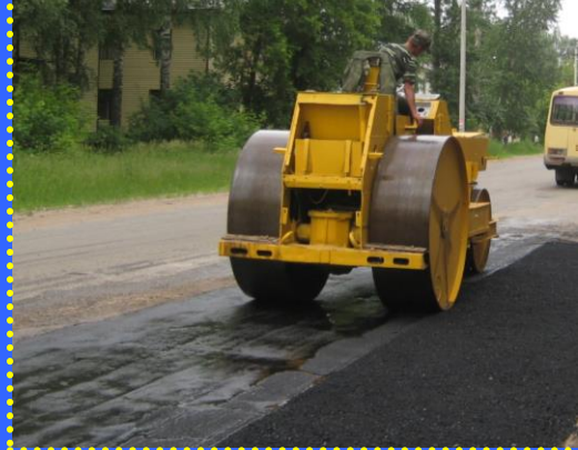
Произведен ремонт дорог и тротуаров
