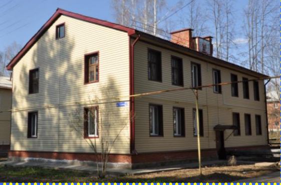
Выполнен капитальный ремонт в 8-ми многоквартирных жилых домах
