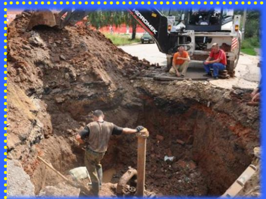
Реконструкция и ремонт водопроводов
